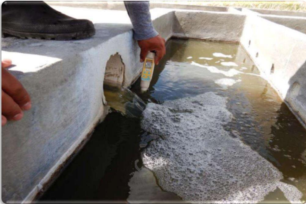
**Foto 12. Se observa presencia de espumas por los residuos de los tensoactivos procedentes de los detergentes, a la entrada del F. A. F. A.**
